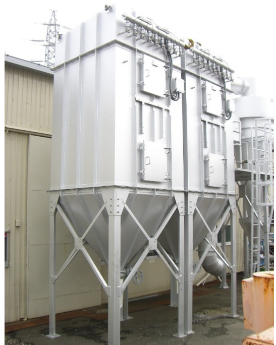
バグフィルター据付
