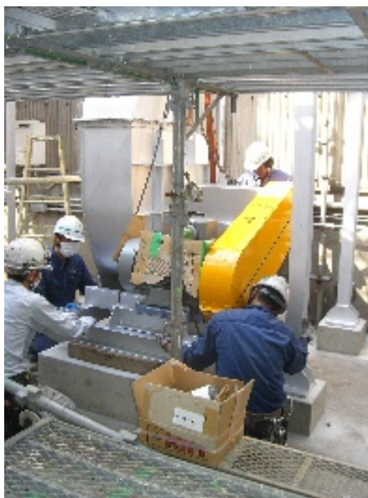
ブローヤ据付
