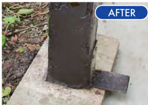
強化樹脂による補強回復
