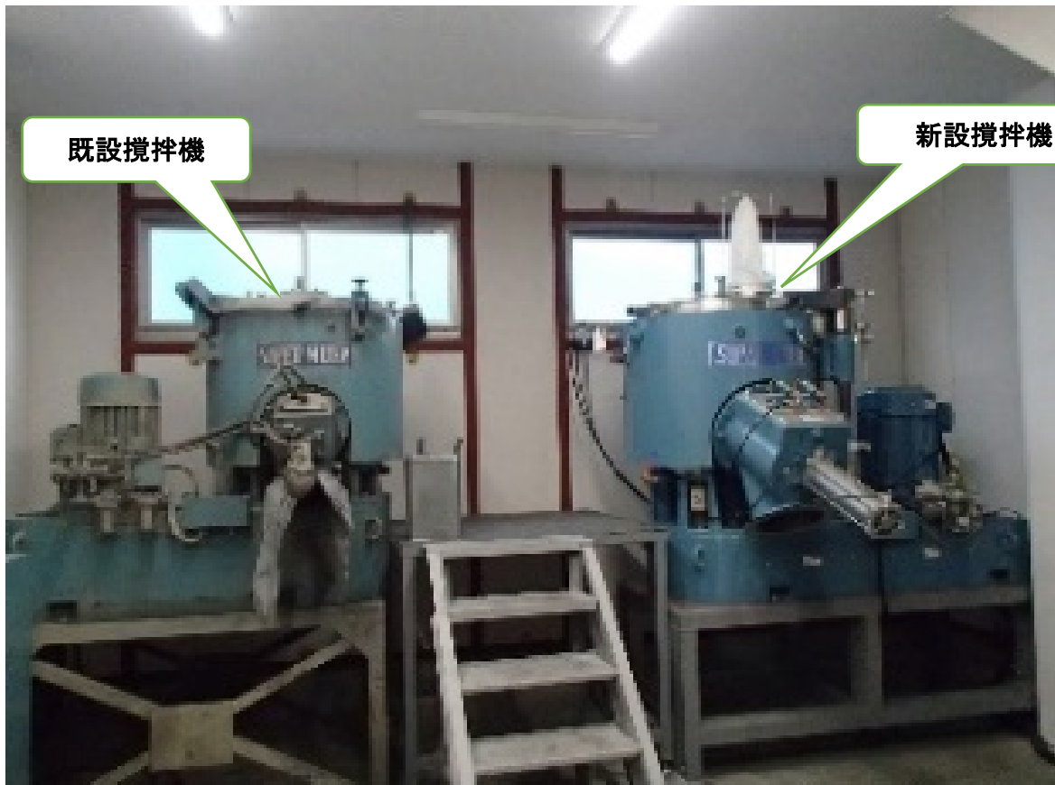
集中配管施工前 既設生産機と増設生産機
