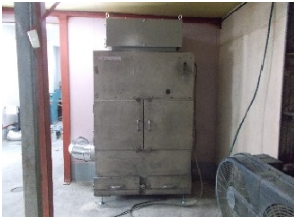
整備・改造済の集塵機据付 (作業室外)
