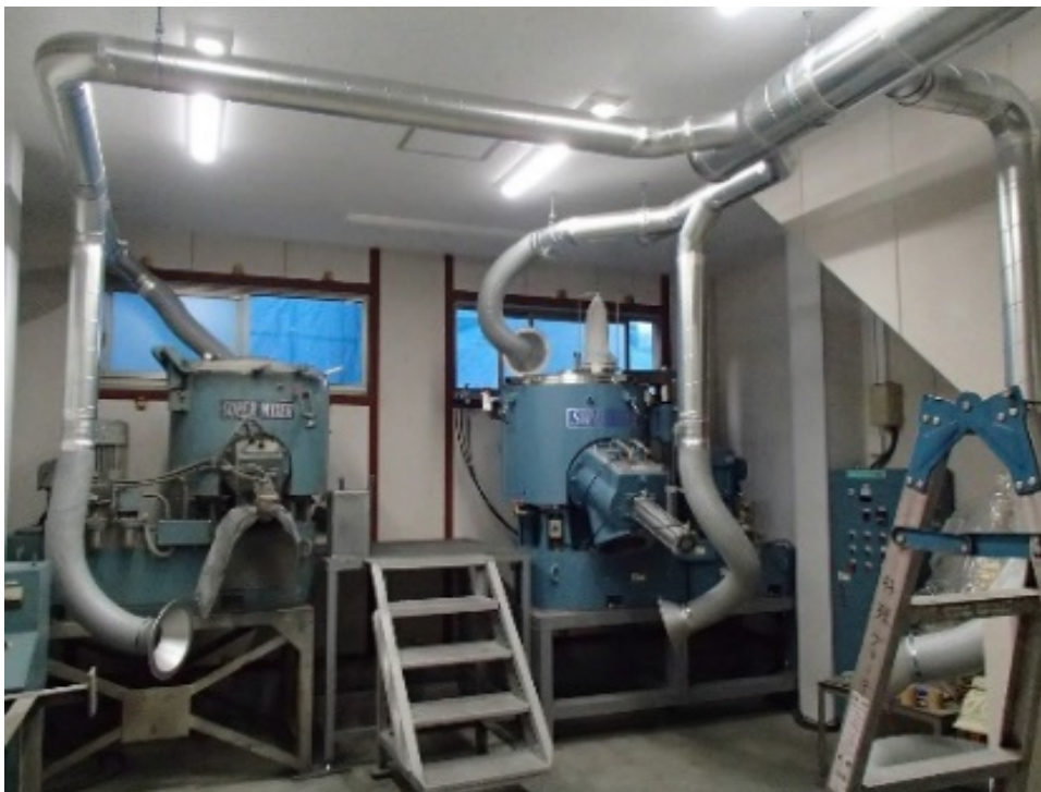
全体集中集塵配管と自在フード
