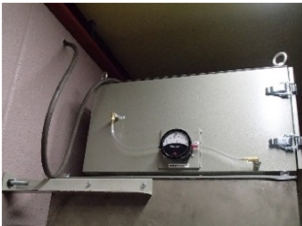
中性能フィルターボックスの取付 (排気配管を不要にする)
