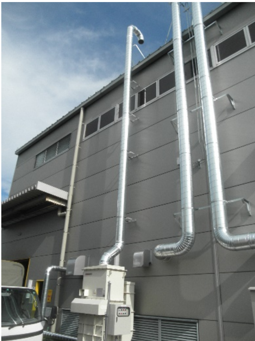
屋外の排気配管は、工場棟屋上まで施工
