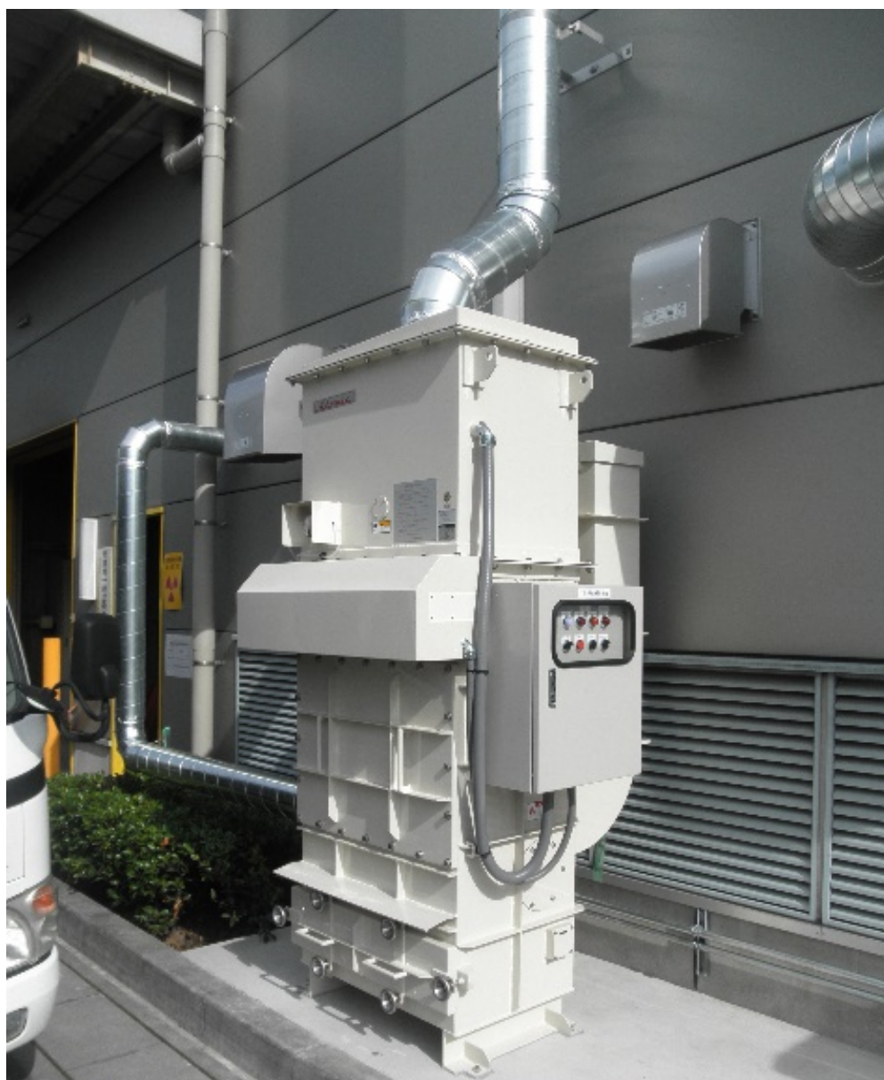
集塵装置本体 2.2kWパルス式 耐圧防爆モーター、爆発放散口付仕様
